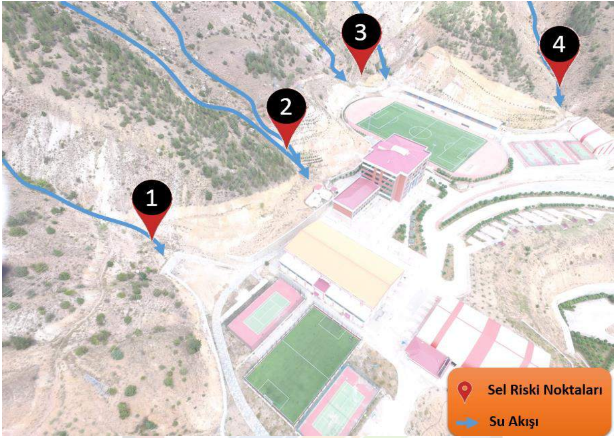
Şekil 7: Merkez yerleşkesinde yağışlar sonrası gelen yüzey suları ve drenaj problemleri.
