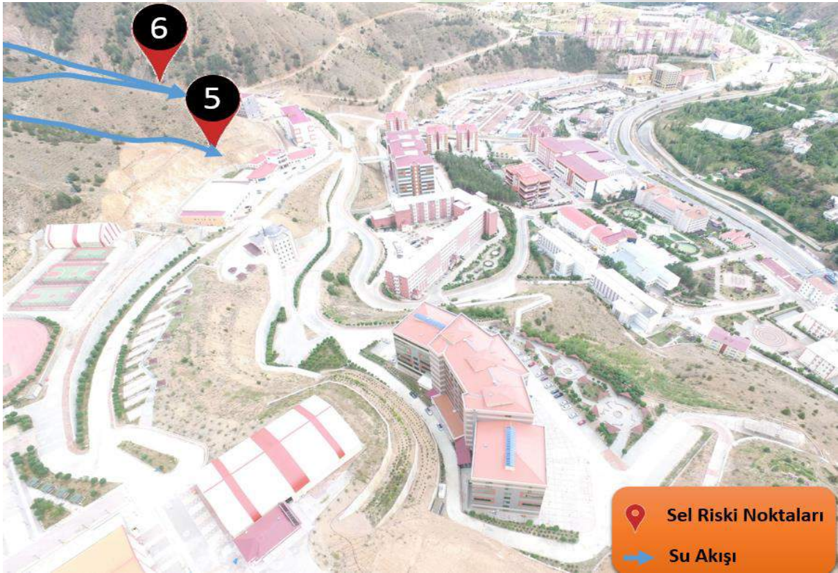
Şekil 8: Merkez yerleşkesinde yağışlar sonrası gelen yüzey suları ve drenaj problemleri.
