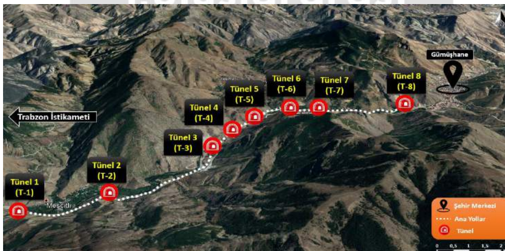
Şekil 7. Torul (Trabzon İstikameti) ve Gümüşhane Merkez arasında ulaşımı sağlayan 8 tünel ve konumları.
